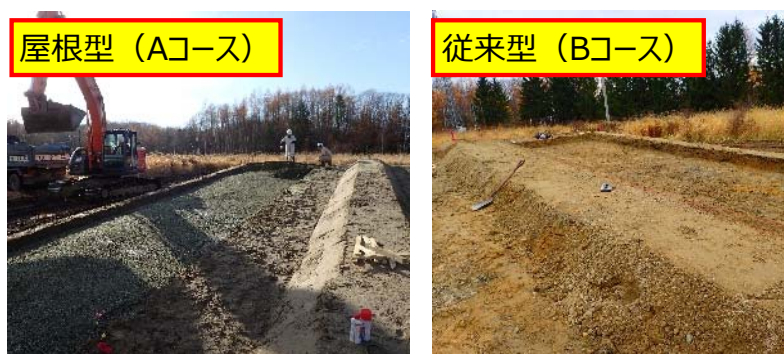
写真1 試験用林道構築の様子
