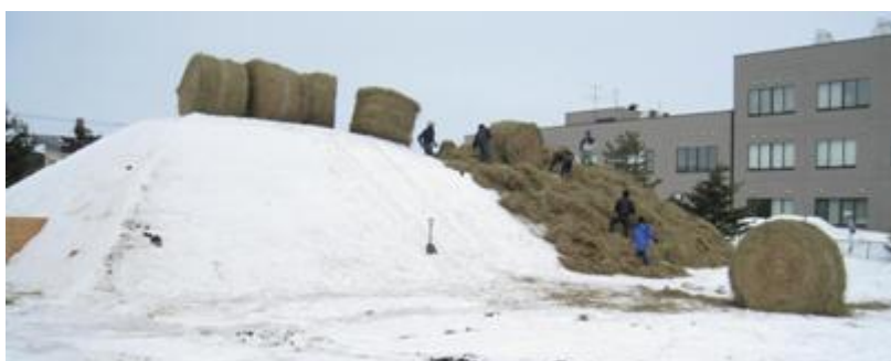
図1 貯蔵用の雪山造成作業風景(牧草敷設作業中)
